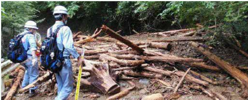
村道での被災状況調査
