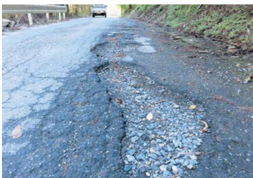
陥没した道路
