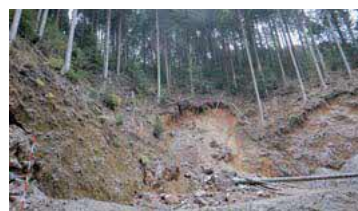
作業道上小鶴線災害箇所
