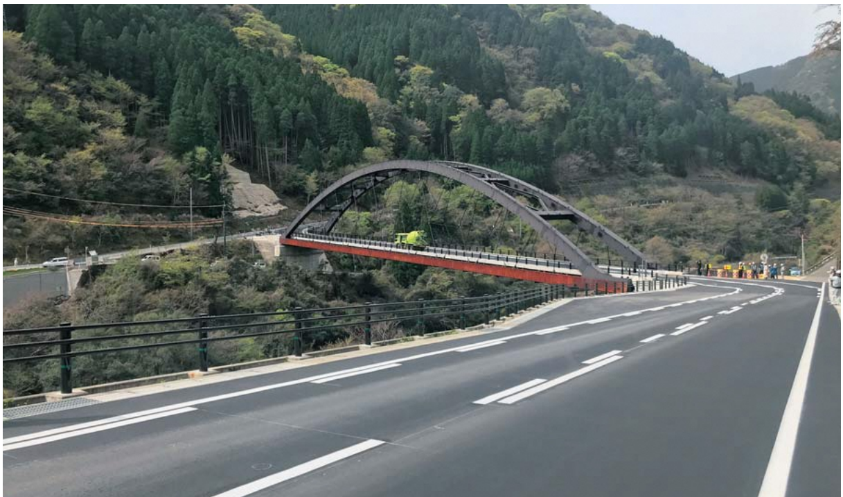
供用開始された国道445号と九折瀬橋
