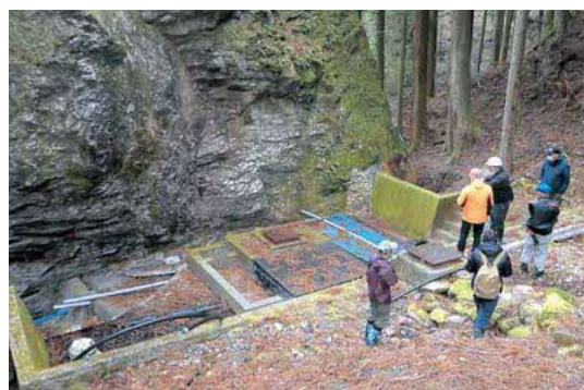
簡易給水施設 現地視察
