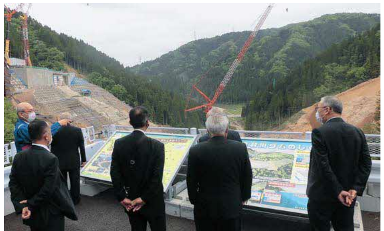
足羽川ダム本体工事
