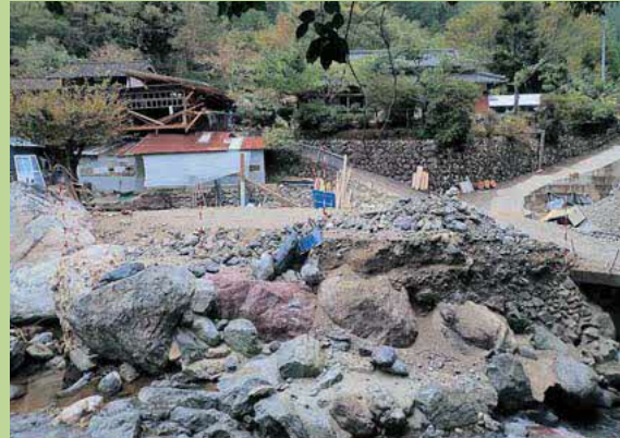
元井谷河川（災害復旧）
