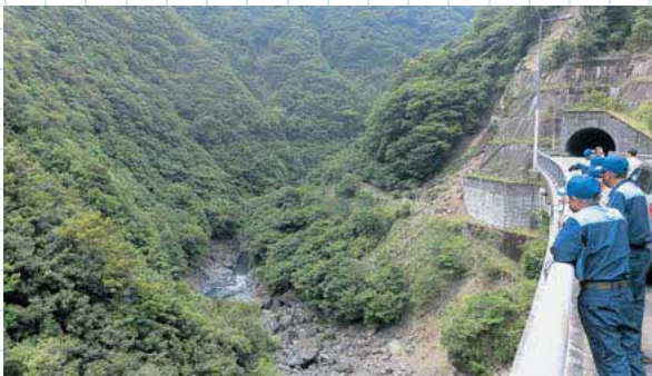
五木ダム予定地（上荒地地区）
