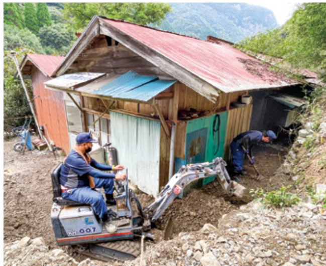
重機を活用した土砂出し
