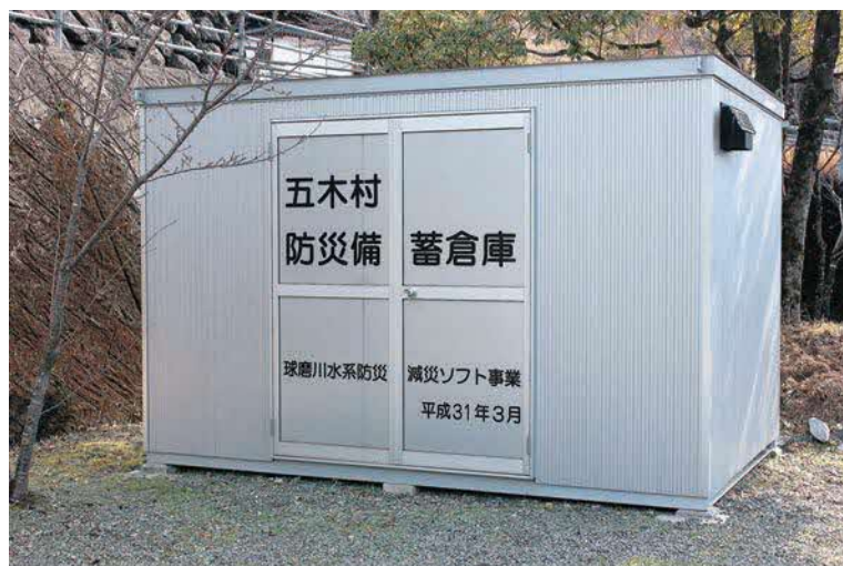
頭地地区に設置されている防災備蓄倉庫
