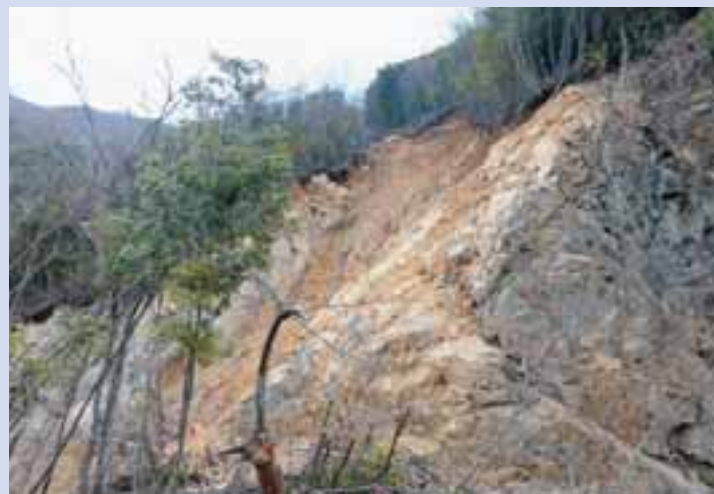
林道空舎線(地山が動いている)
