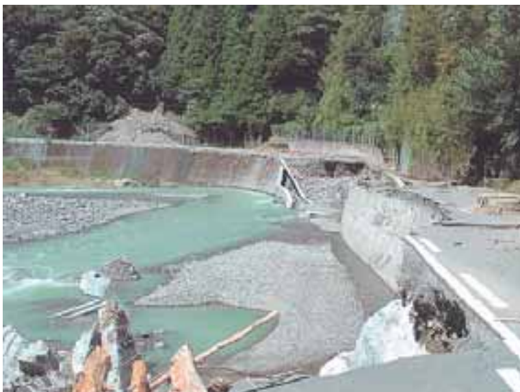
昨年7月水害により決壊した県道宮原五木線
