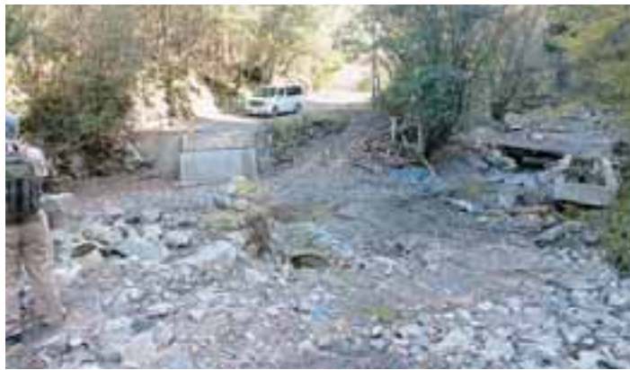
橋梁が流された村道折立線
