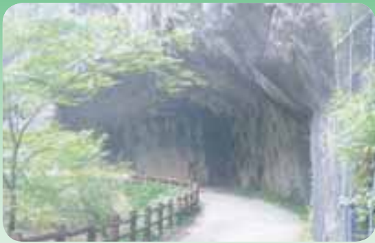
旧主要地方道宮原五木線 (片(半)トンネル)
