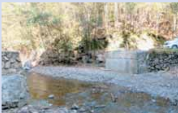
流出した橋梁（桁部分）
