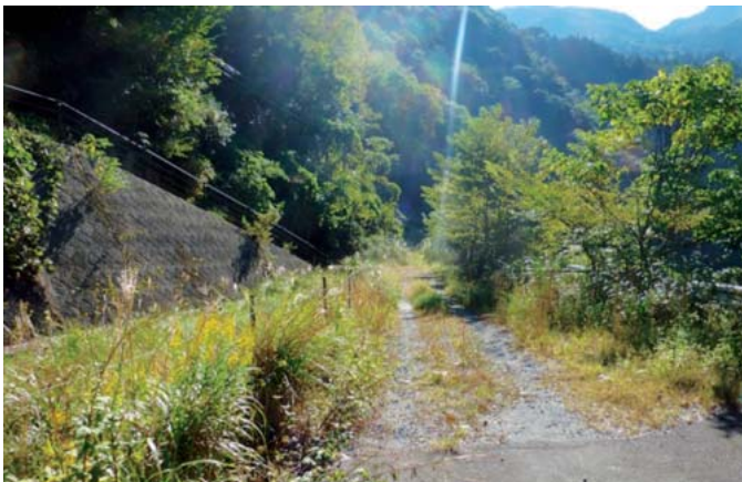
国道445号未改良終点側（神屋敷住居跡）
