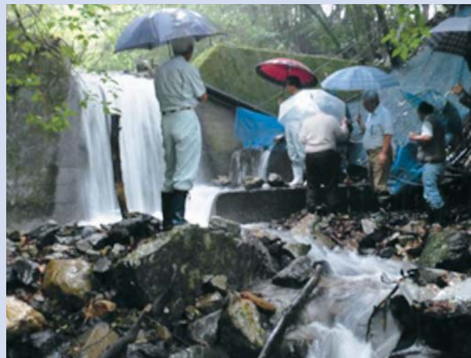
取水堰と取水槽
