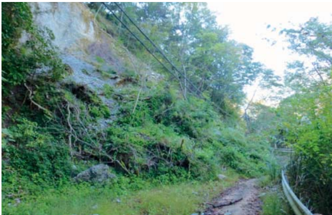
崩壊している法面（旧九折瀬バス停付近）
