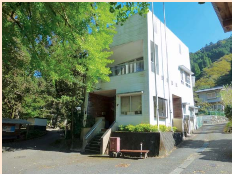
解体予定の北公民館（宮園）
