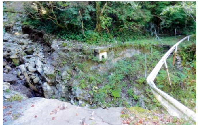
旧道が欠損している区間（旧九折瀬バス停付近）
