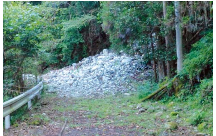
流出した岩砕（下流側より）
