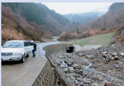
一部復旧が完了した林道相良五木線
