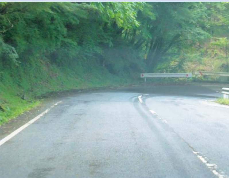
流水により冬場に凍結する路面
