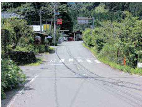
国道445号の狭隘部(宮園地区)
