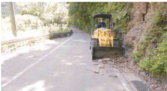
梅雨前の落石・側溝対策の作業の様子
