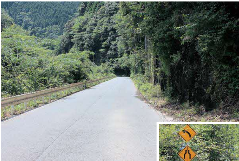
県道宮原五木線(県道25号)の改良が待たれる狭隘部(椿地区)
