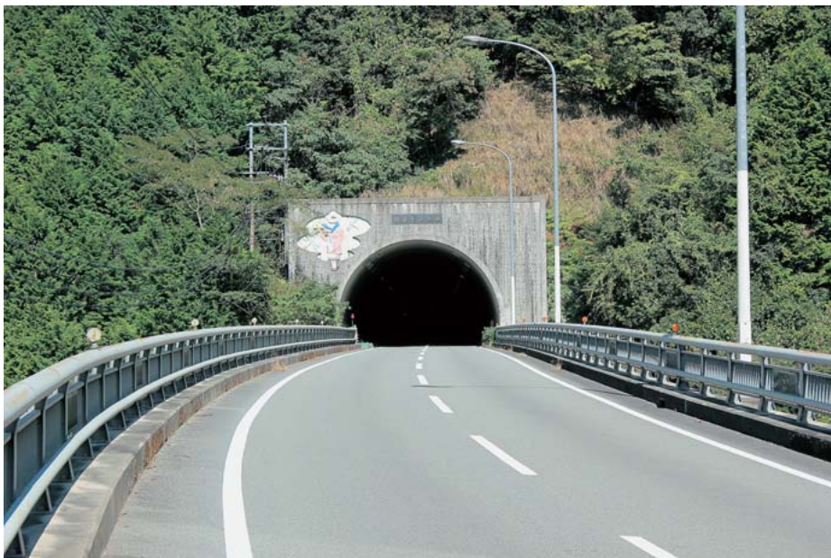
瀬目トンネル (人吉側より)
