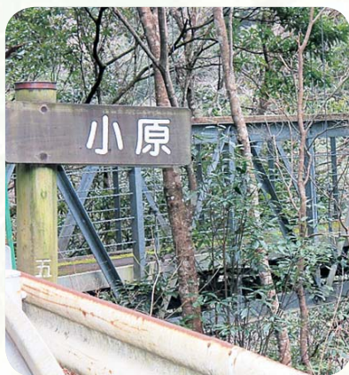
小原の吊り橋
