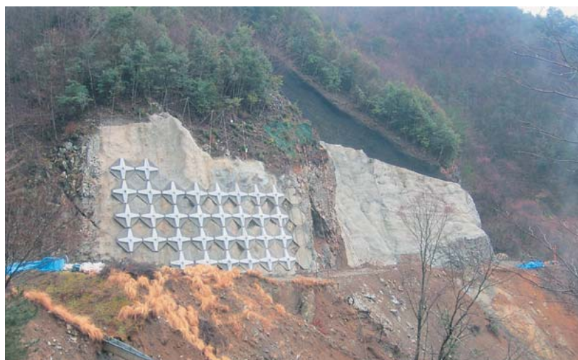
林道空舎線災害現場
