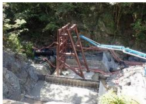
入鴨川第8砂防堰堤の施工状況
