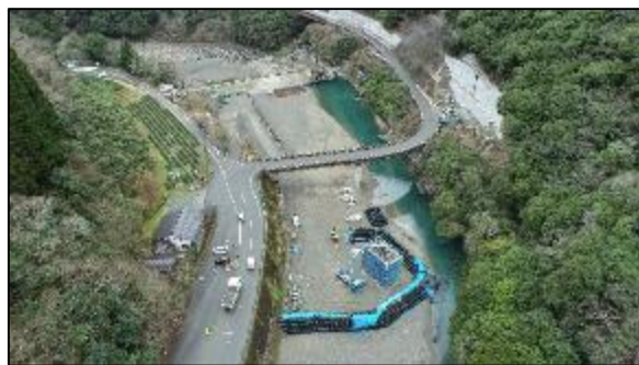
新神屋敷橋下部工の施工状況
