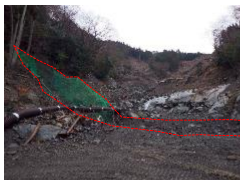
野々脇地区（施行中：床掘状況）
