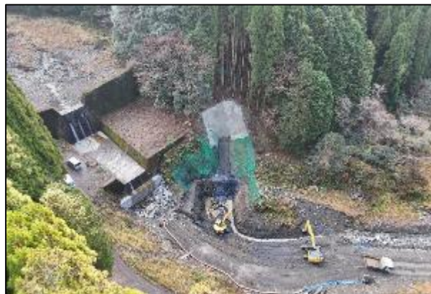
横手谷川砂防堰堤3の施工状況
