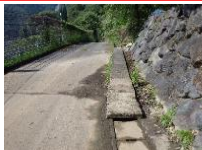
側溝の補修
