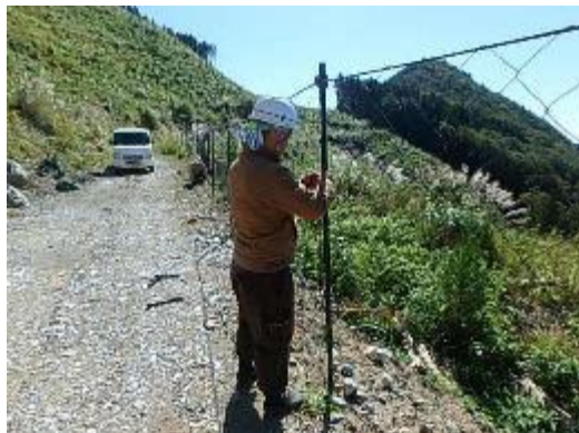
シカ防護柵の設置状況
