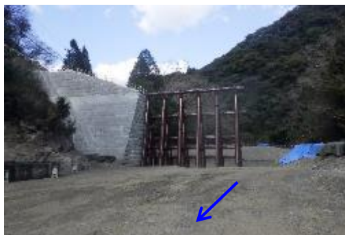
小川第2砂防堰堤工事の施工状況
