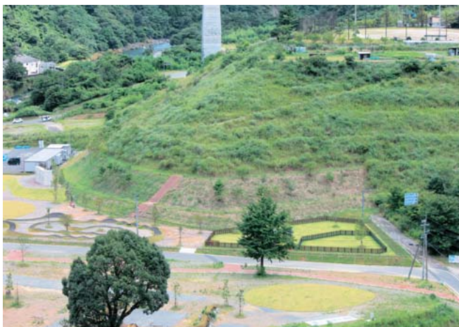
水没予定地東部エリアの法面
