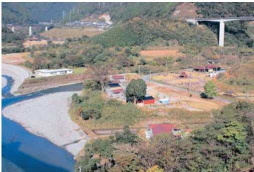
工事中の五木村コテージ及び森の遊び場
