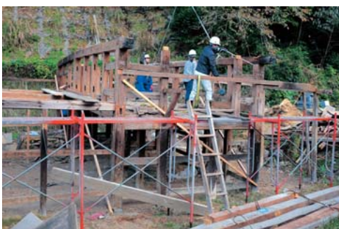
協力隊による解体作業イベント
