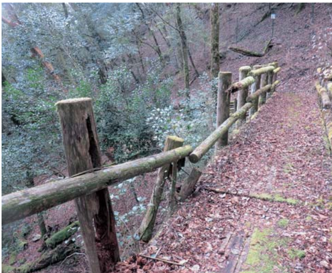
朽ちて危険な手すりも…
