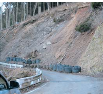
林道災害箇所
