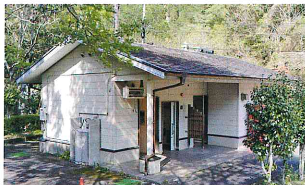
瀬目公園トイレ
