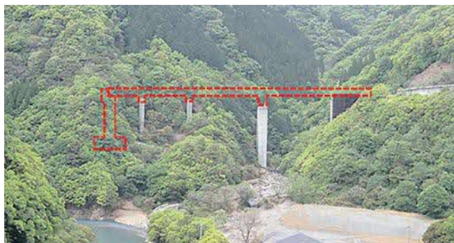
未着工の逆瀬川橋梁
