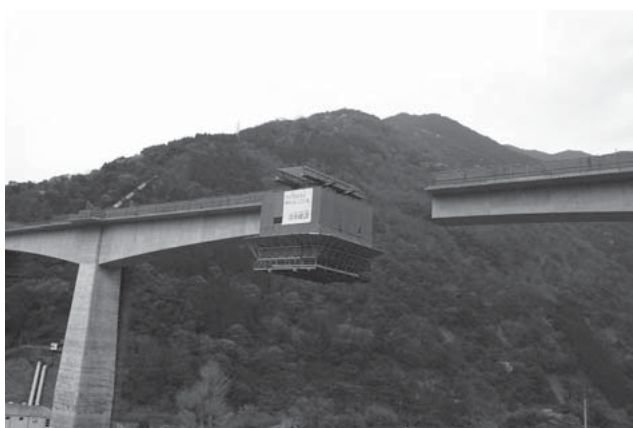
完成が待たれる頭地大橋
