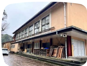
体育館の外観
