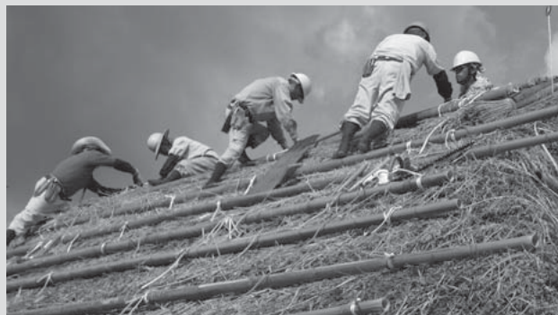
かやぶき職人による葺き替え工事の様子
