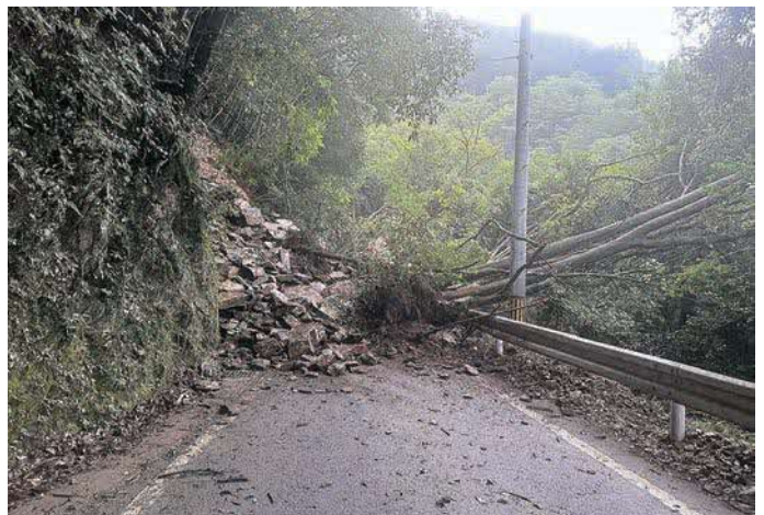
村道葛ノ八重線災害現場
