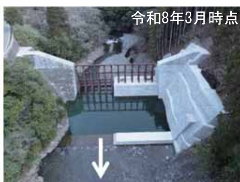
小川第2砂防堰堤工事の施工状況
