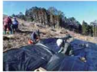
生分解性防草シートの施工
