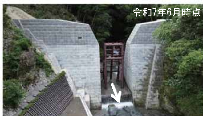
入鴨川第8砂防堰堤の完成
