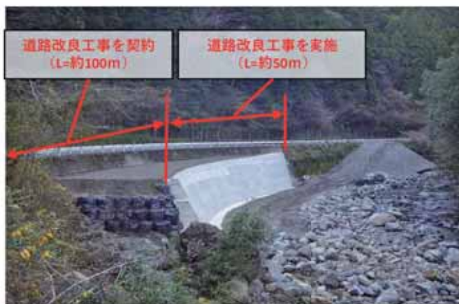
樁工区の施工状況
