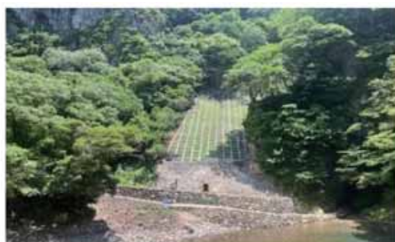
北平地区（白滝公園）（山腹工完了）
