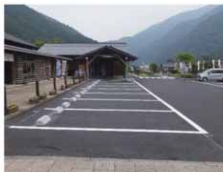
舗装改修工事の完了状況
