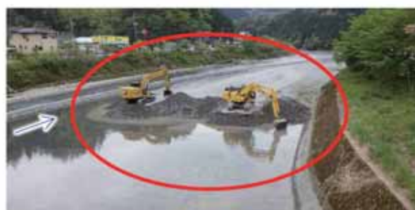
土砂掘削状況（宮園橋下流）
