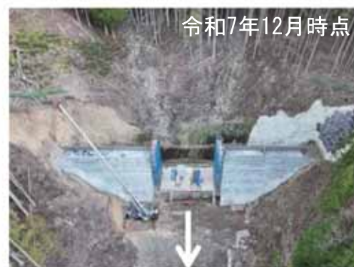
縦木川第3砂防堰堤工事の施工状況
