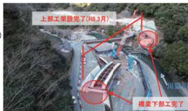
九折瀬工区の施工状況
