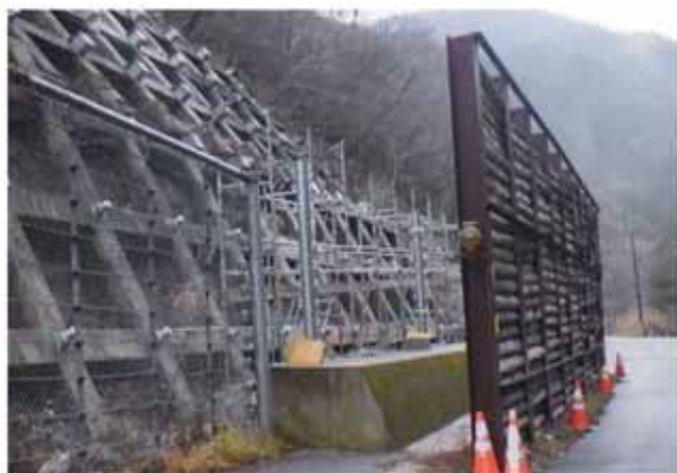
道路防災対策の実施（葉木工区(八代市)）
