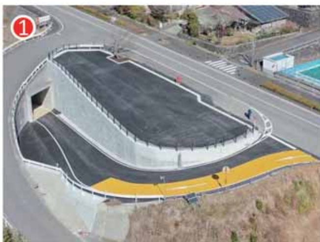
整備完了(村道間平場)
