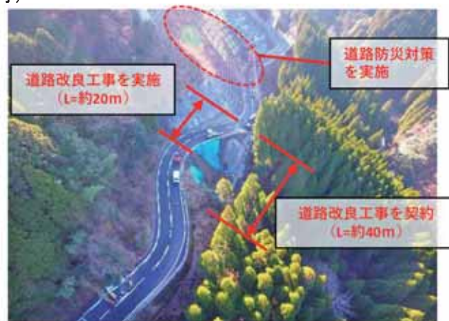
河俣工区(八代市)の施工状況
