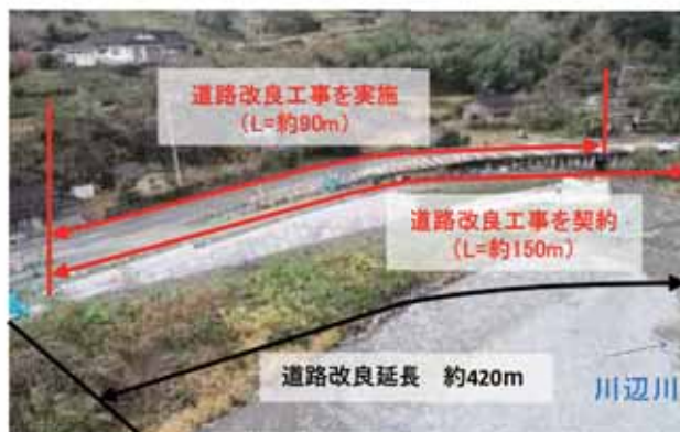
上下坂工区(相良村)の施工状況
