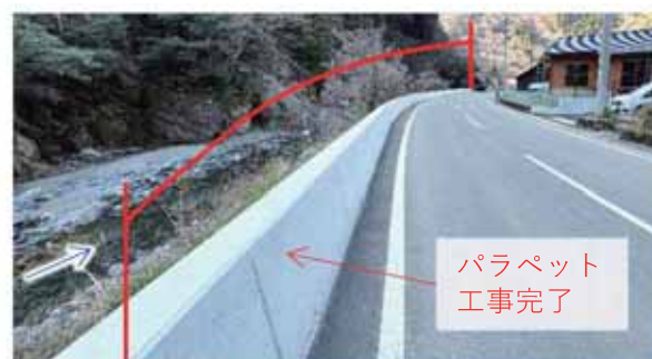
堤防整備（パラペット）
