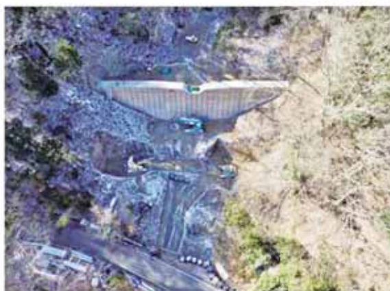
下梶原A地区（谷止工施工中）
