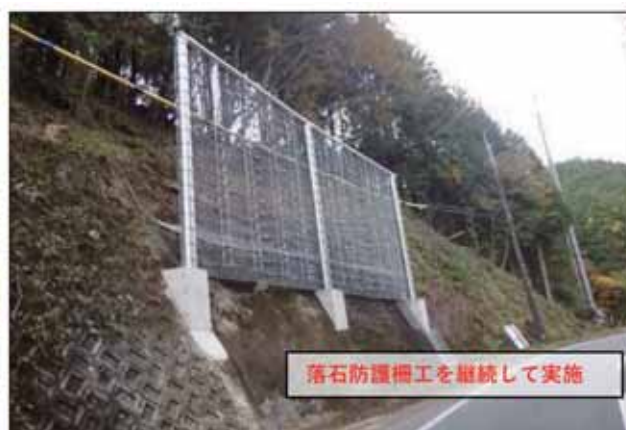
道路防災対策（五木村工区）
