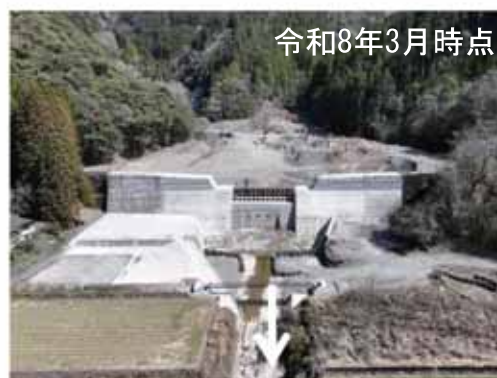
横手谷砂防堰堤改築工事の施工状況
