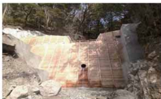
屋敷地区（谷止工完了）
