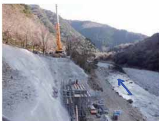
三方谷地区 道路復旧（復旧中）
