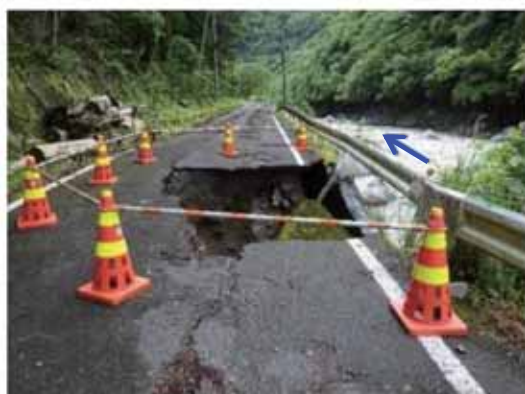
溝口地区 道路復旧（着手前）
