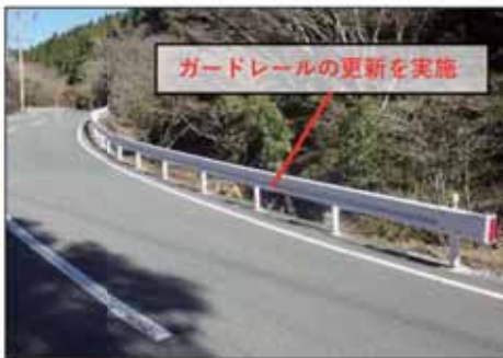
ガードレールの更新(小椎葉地区)
