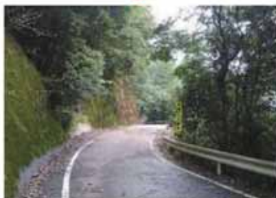
堆積土砂撤去後
