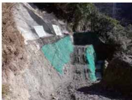
野々脇地区 道路復旧（復旧中）
