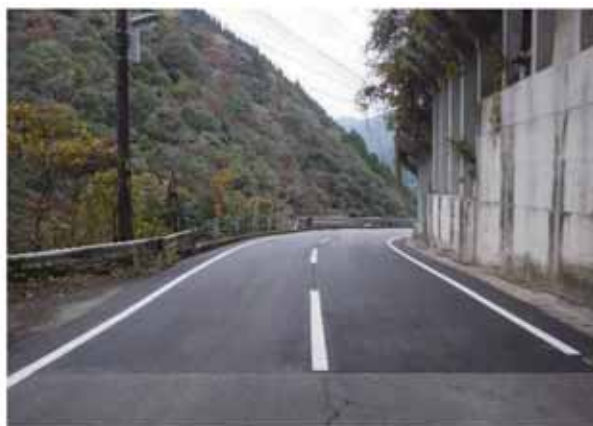
舗装補修の実施（上荒地地区）
