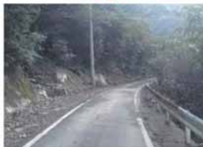
堆積土砂撤去後
