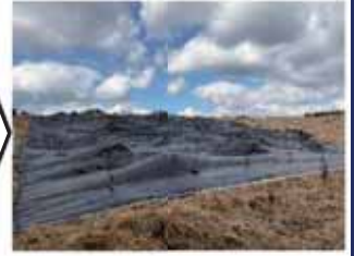
生分解性防草シートの施工
