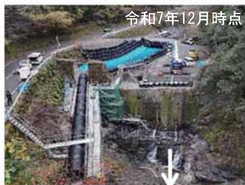
小川砂防堰堤改築工事の施工状況
