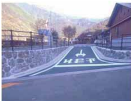
取付道路工事の完了状況
