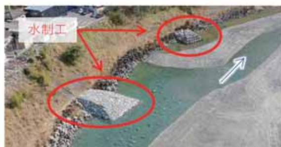
水制工試験施工
