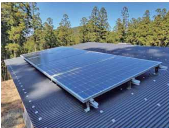
ソーラーパネル設置
