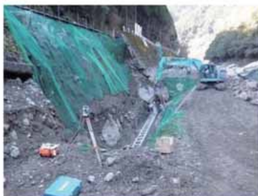
溝口地区 道路復旧（復旧中）
