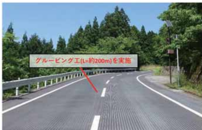
凍結抑制対策の実施（河俣工区(八代市)）
