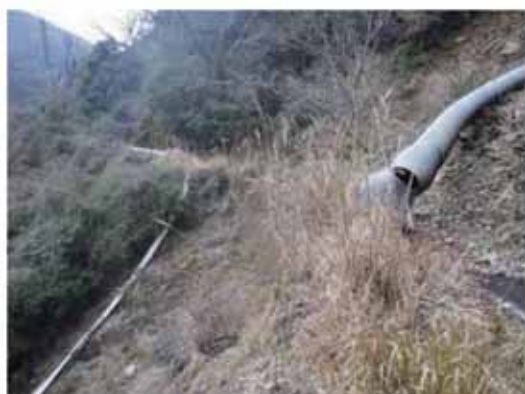
野々脇地区 道路復旧（着手前）
