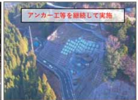
道路防災対策(八代市工区)
