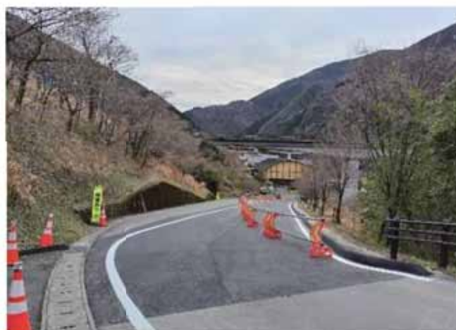
村道中学校線（舗装完了）
