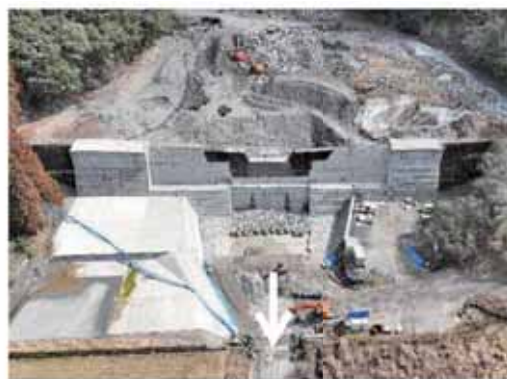
横手谷砂防堰堤改築工事の施工状況
