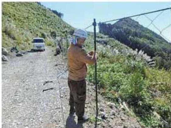
シカ防護柵の設置状況
