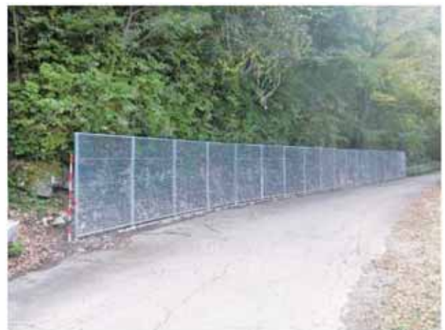
簡易防護柵工事の実施状況（五木湯前線）
