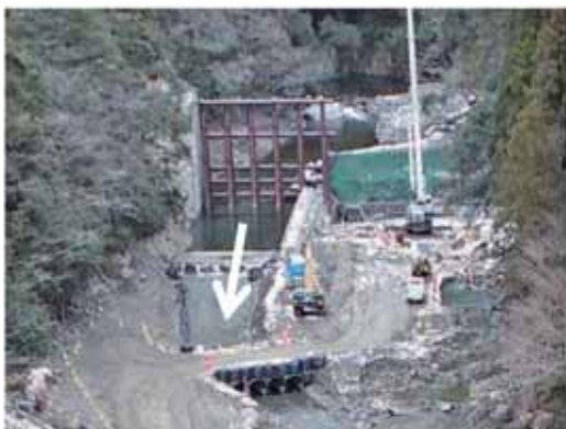
小川第2砂防堰堤工事の施工状況
