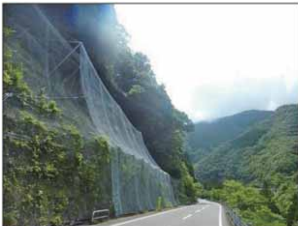
斜面对策工事の実施状況（九折瀬工区）
