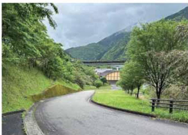
村道中学校線（着工前）
