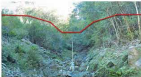
上荒地地区（荒廃状況）
