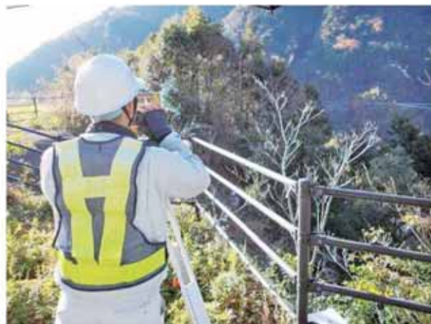
測量 実施状況
