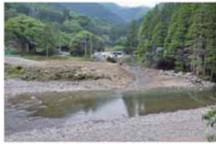
堆積土砂撤去後
