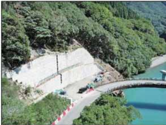
道路改良工事の施工状況（九折瀬工区）
