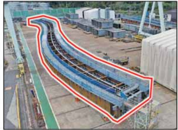
新神屋敷橋（仮称）上部工の製作状況（九折瀬工区）
