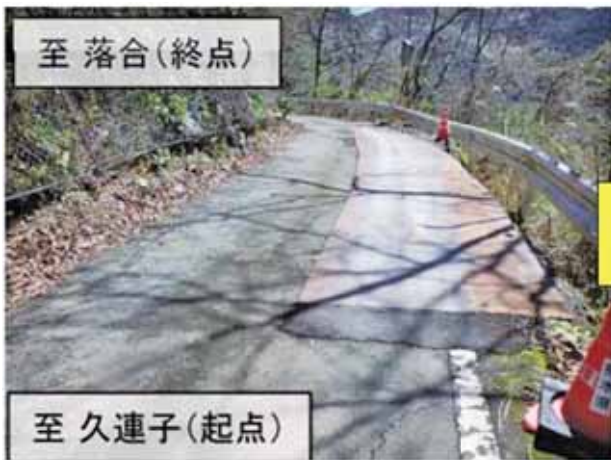
路肩補修等工事の実施状況（久連子落合線）
