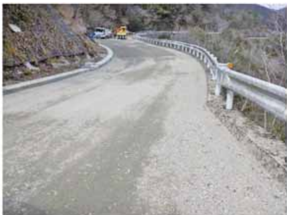
付替村道逆瀬川地区の整備状況
