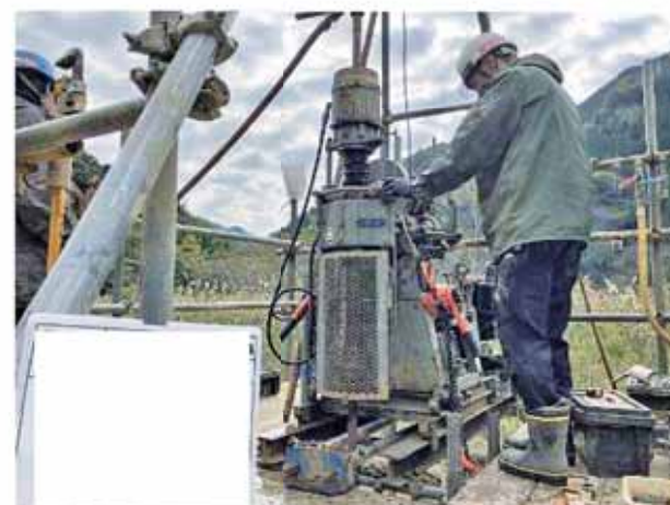
地質調査 掘進状況
