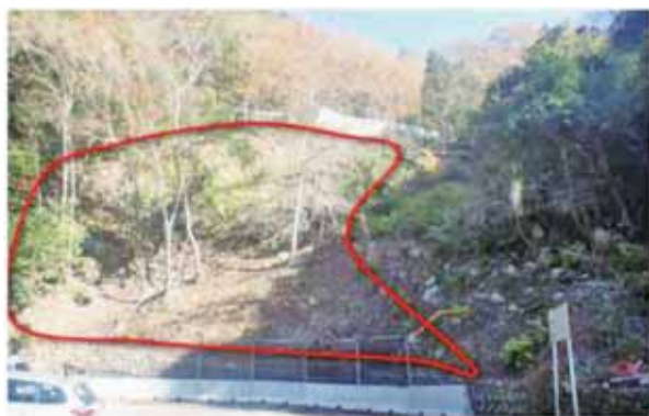
下梶原地区（荒廃状況）
