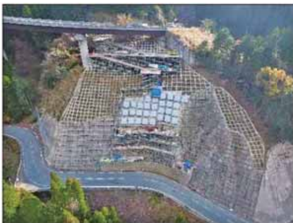
斜面对策工事の実施状況（河俣工区）
