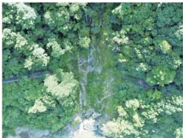
小浜地区 道路復旧（着手前）
