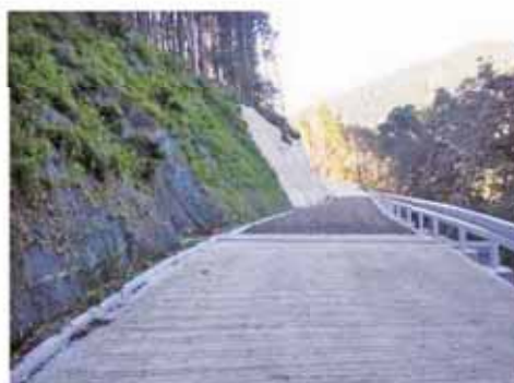
林道開設状況 （急こう配区間はコンクリート路面）
