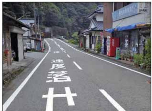
区画線工事の実施状況
