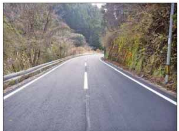
舗装補修工事の実施状況（五木村）
