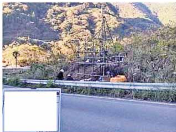
地質調査 全景
