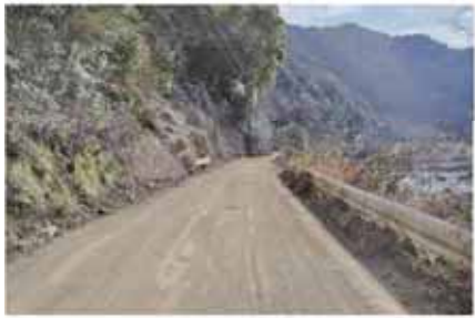
堆積土砂撤去後
