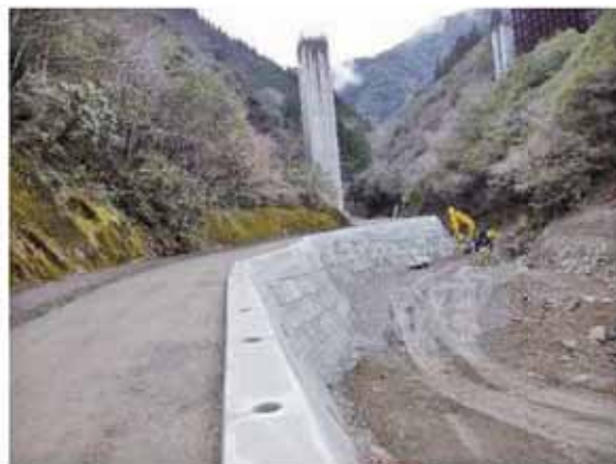
工事用道路の復旧状況
