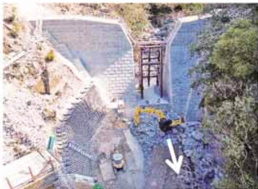
入鴨川第8砂防堰堤工事の施工状況
