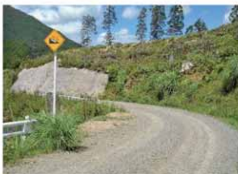
林道開設状況（砂利道）
