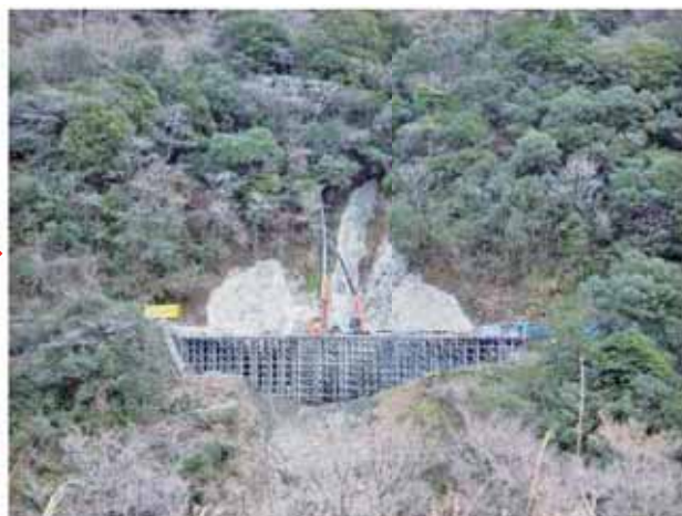
小浜地区 道路復旧（復旧中）
