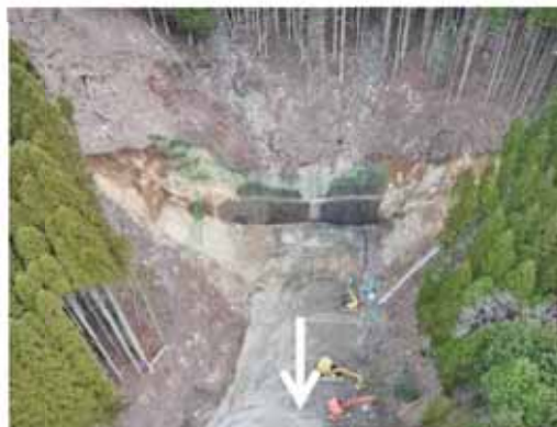
縦木川第3砂防堰堤工事の施工状況
