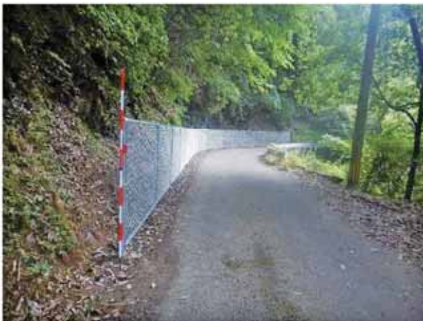
簡易防護柵工事の実施状況（久連子落合線）
