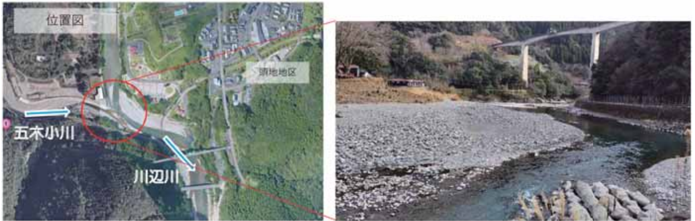
堆積土砂撤去（川辺川・五木小川の合流点）
