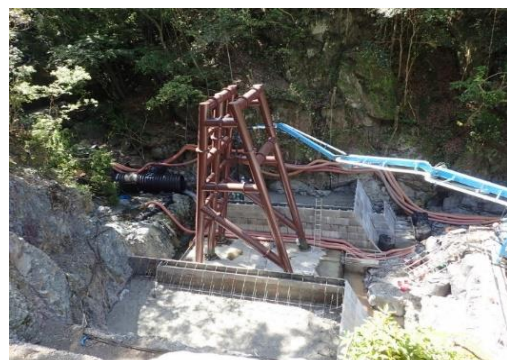
入鴨川第8砂防堰堤の施工状況
