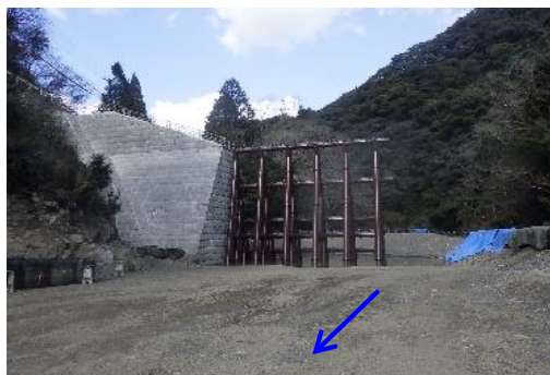
小川第2砂防堰堤工事の施工状況
