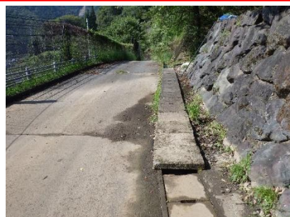
側溝の補修
