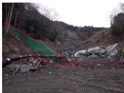
野々脇地区（施行中：床掘状況）
