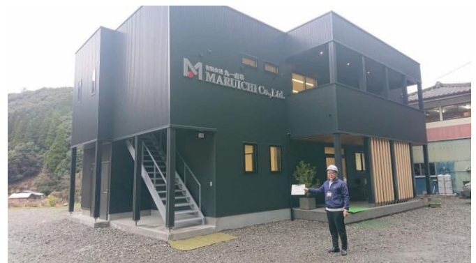
次世代を担う事業者支援補助金を活用し新築された建物
