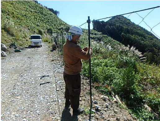
シカ防護柵の設置状況
