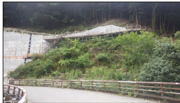
道路改良工（地山補強土壁）の施工状況
