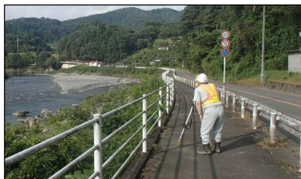
道路測量業務の状況
