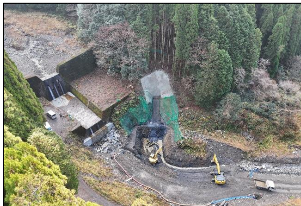
横手谷川砂防堰堤3の施工状況
