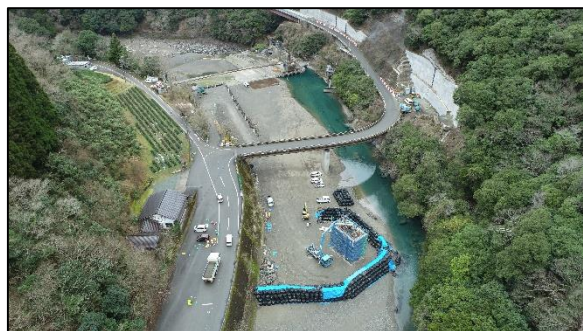
新神屋敷橋下部工の施工状況
