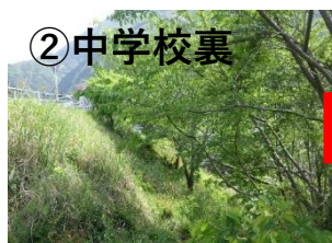
②中学校裏 着工前
