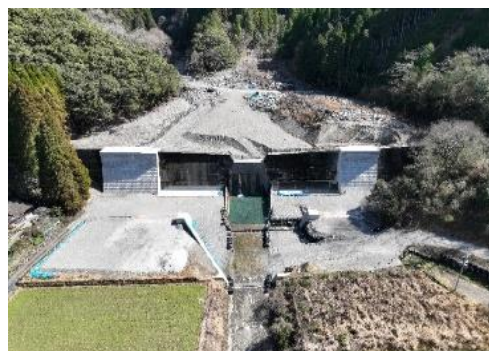
横手谷砂防堰堤改築工事の施工状況
