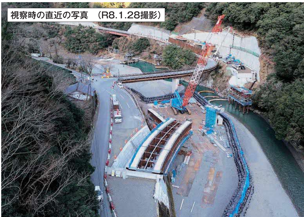
最新の施工状況写真① (R8.3.27撮影)
