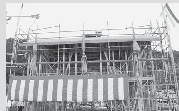
棟が上がった第3分団1部の消防ポンプ格納庫
