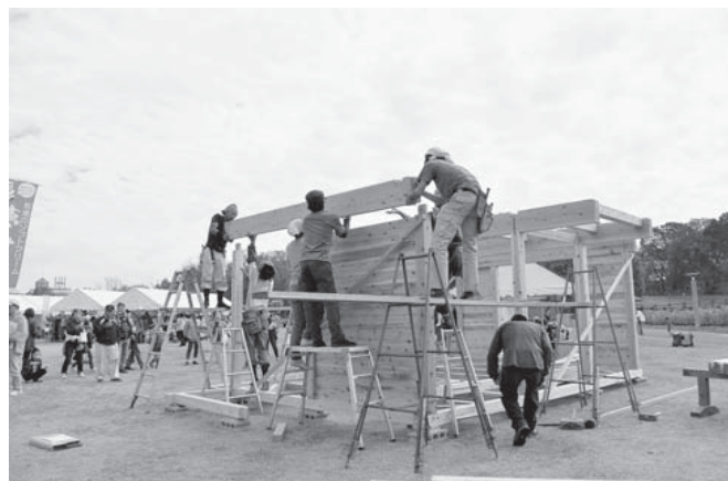
手際よく組み立てていく大工の皆さん
