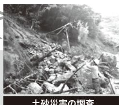
土砂災害の調査
