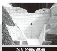
砂防設備の整備
