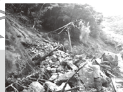
土砂災害の調査
