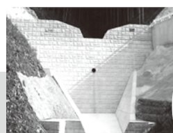
砂防設備の整備
