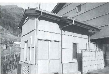
情報通信基盤整備に伴い、役場に設置されたセンター施設
