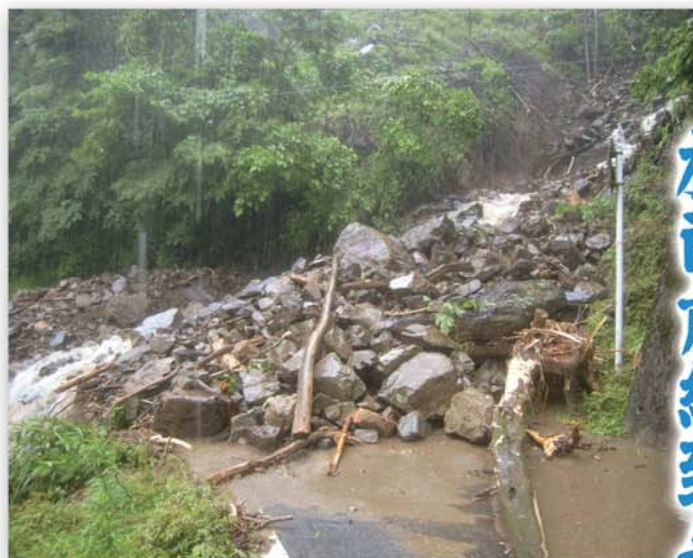
落石・倒木が路上に積み重なる(県道久連子落合線平沢津方面)
