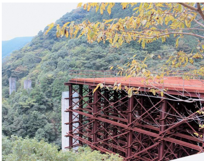
工事が中断したままの付替道路（逆瀬川）
